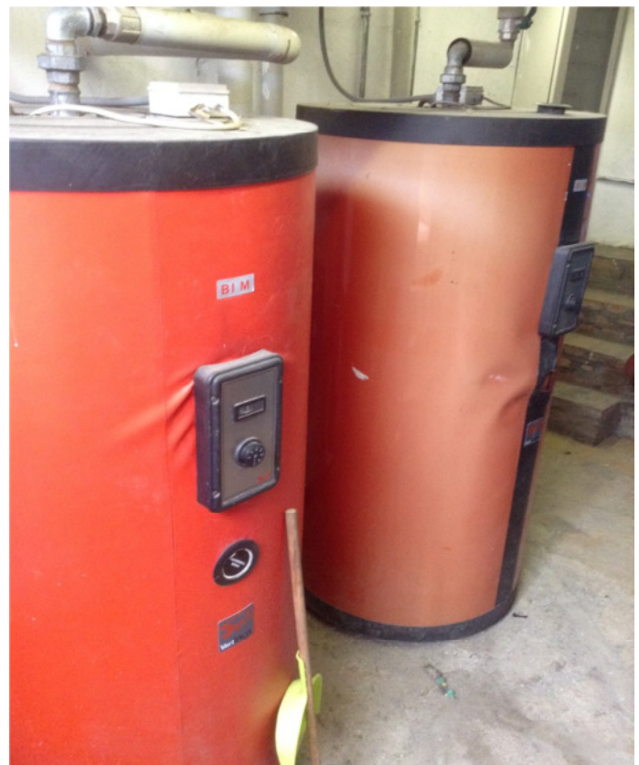
Sistema di produzione dell'acqua calda sanitaria attraverso due bollitori
