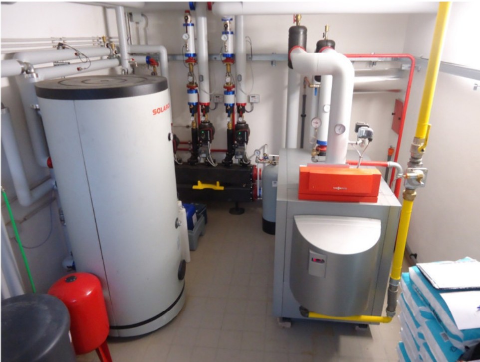
Vista della nuova centrale termica dopo l'intervento di ristrutturazione
