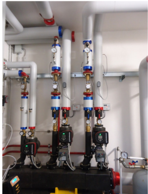
Vista del collettore pompe e dei misuratori di energia installati sui circuiti di riscaldamento e produzione acqua calda sanitaria.
